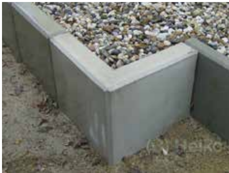
Abb.120 Betonkantenstein mit Schotterfüllung
