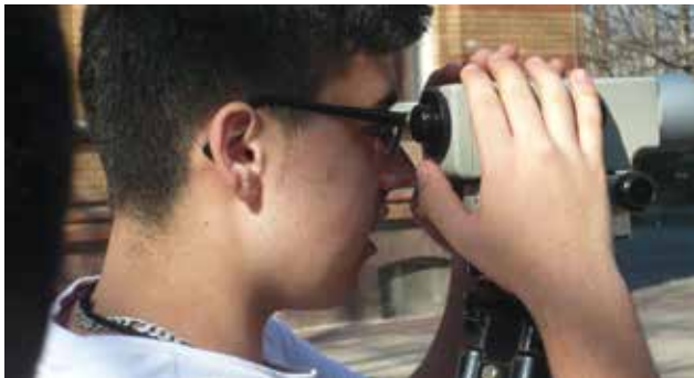
Abb.25 Einmessen eines Höhenpunktes
